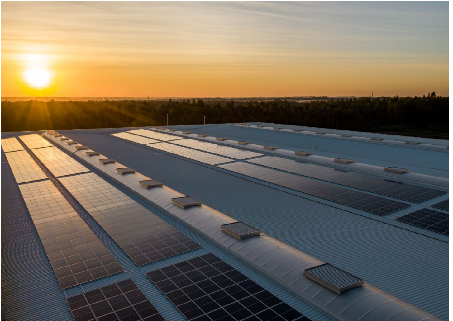
工商业屋顶太阳能电站
